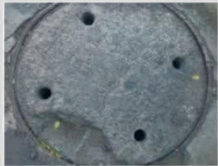
شکل ۴: نمونه دریوش (چدن بتن) دچار سایش شده به طوری که آرماتورها نمایان شده اند.
